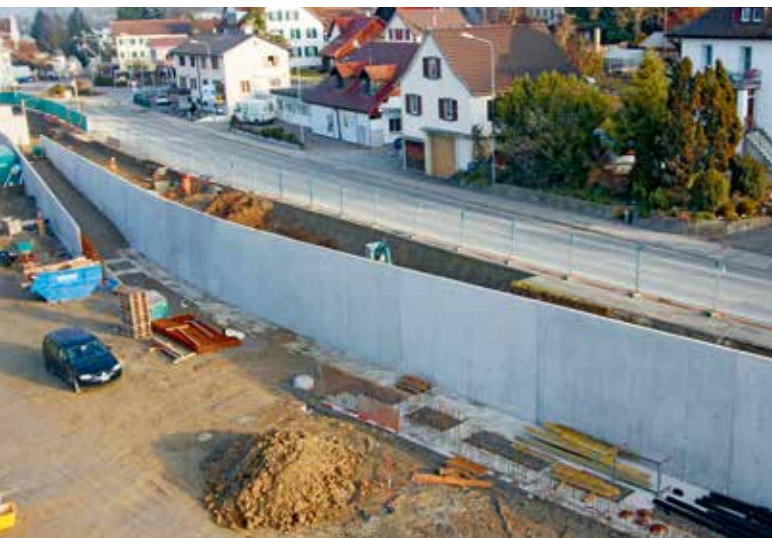
Schutz vor Hochwasser und Einfassung für den künftigen Eingangsbereich
